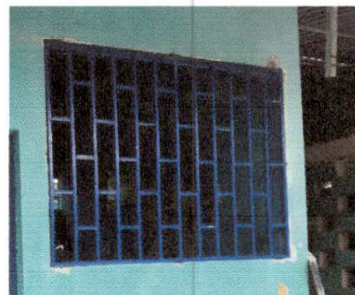
Foto 4: SUSTITUCION DE BALCONES DE METAL, EN COCINA Y AULAS
