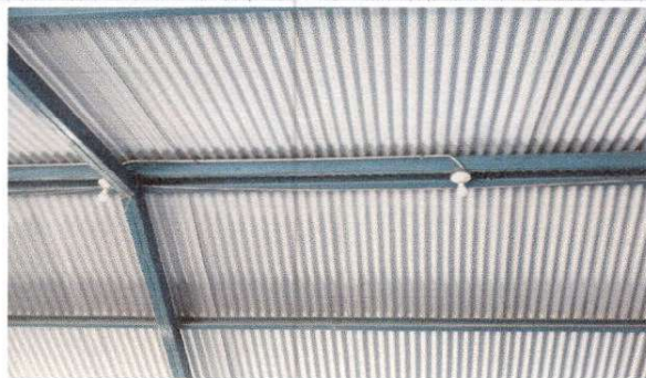
Foto 8: SUSTITUCION DE FOCOS AHORRADORES, Y PLAFONERAS, EN TODOS LOS MODULOS
