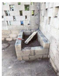
Foto 10: SUSTITUCION DE PILA DE CEMENTO, (TANQUE), AREA DE COCINA
