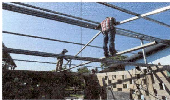
Foto 2: SUSTITUCION DE ESTRUCTURA DE MADERA, POR METAL, AREA DE COCINA
