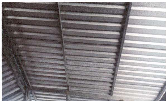
Foto1: Sustitución de lámina, por lámina troquelada aluzinc calibre 26. En cocina
