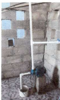
Foto 9: SUSTITUCION DE BOMBA DE AGUA, AREA DE COCINA
