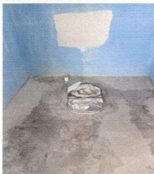
Foto 7: SUSTITUCION DE INODORO (INCLUYE INSTALACION Y MATERIALES) BAÑOS
